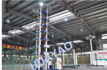
陡坡冲击试验 Steep-front impulse voltage test
