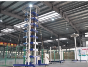
陡坡冲击试验 Steep-front impulse voltage test
